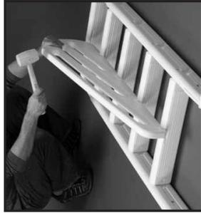
**Étape 2-6 :** Couchez l'échelle et installez la barrière anti-enclèvement en l'enclenchant dans les entailles situées sur le dessus des marches. Insérez la partie inférieure en premier.
