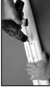
**Étape 1-2 :** Raccordez les montants supérieur et inférieur en vous servant de deux boulons #20 x 1/4 po x 7/8 po et de deux écrous hexagonaux 1/4 po - 20. Répétez la procédure jusqu'à ce que tous les quatre montants soient assemblés.
